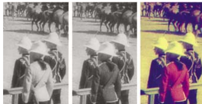
Цветоделённый позитив и цветное изображение на экране по системе «Kinemasolor» их фильма «The Durbar At Delhi» («Торжественный приём в Дели»), 1911 г. Верхний кадр снят через красный фильтр, нижний - через зелёный.
