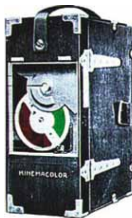
Кинокамера «Kinemacolor» с удалённой передней объективной панелью, за которой на объектюре установлены зелёный и красный светофильтры, через которые происходит цветная съёмка по системе «Kinemacolor»
