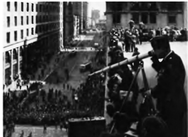
Рис. 3. Применение «органного» микрофона для звукозаписи во время телевизионной трансляции парада Американского Легиона в Нью-Йорке (США). Крыша шестого этажа здания EmpireState, вид на 5 авеню, 1937 год (иллюстрация из [1])
