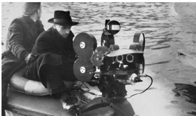
Установка для съёмки панорамного фильма из трёх 35-мм кинокамер
