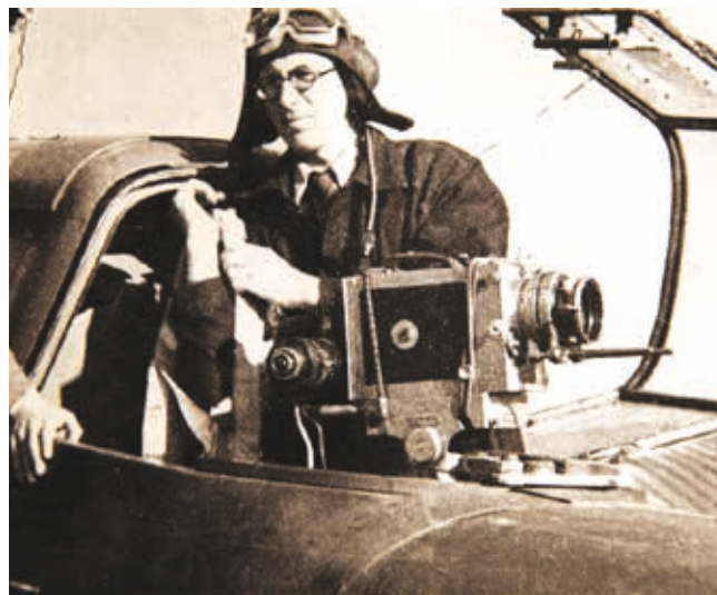
Установка кинокамеры на штурмовике ИЛ-2
